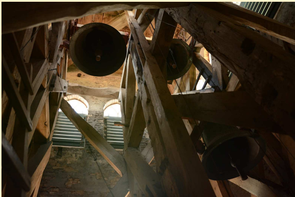
Der mächtige Glockenstuhl, von oben und von unten betrachtet, entstammt möglicherweise dem alten Kirchturm, der vor 1905 dem Neubau weichen musste.
